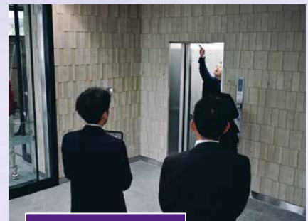
エレベーター
