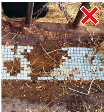
残飼放置・タイル破損
