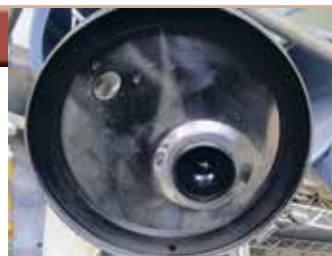
写真1 汚れのつきやすい 上蓋裏側
