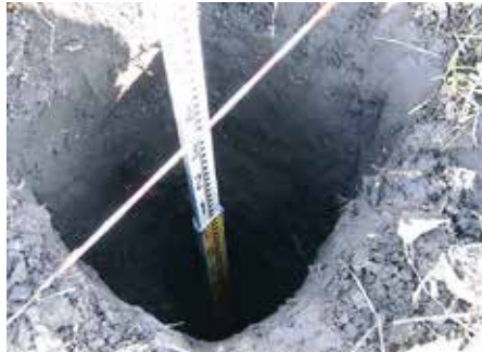
写真2 ③縦孔暗きょの施工
