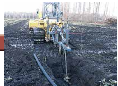
写真4 カッティングドレーン施工
