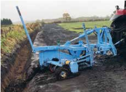
写真1 ①明きょと②カットソイラーの施工
