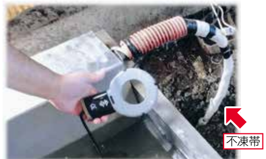
不凍帯をホースに巻き、電熱線を水槽に入れる
