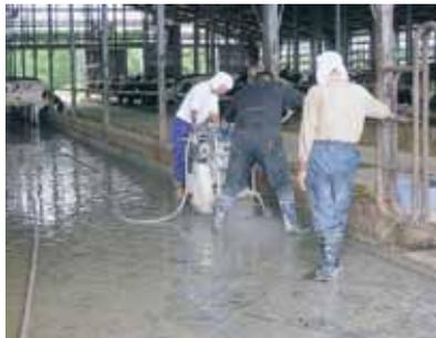
写真2 既存のダイヤモンド目地に専用機でストレート目地を施工する様子
