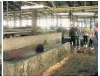
写真5 ヒーターを吊るして水槽周辺の凍結を防止している事例
