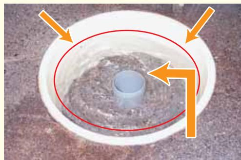
写真3 処理室内に埋め込まれた洗浄槽
