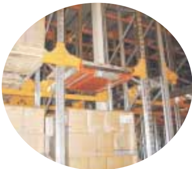
中央の赤いプレートみたいなものがロボット。これが奥まで続くパレットラックを上下前後左右に動き、荷さばきします。
