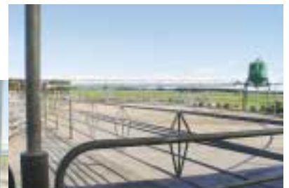
待機場は牛を追い込みながら、円の中心にある穴に向かって勾配を利用して糞尿を掃除します
