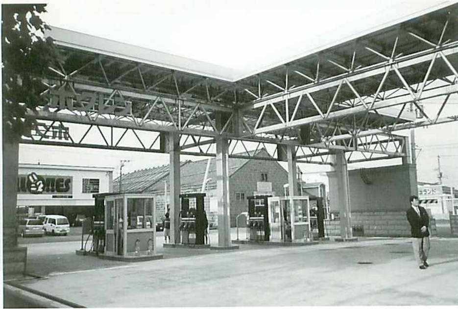
ホクレン小樽有幌給油所
