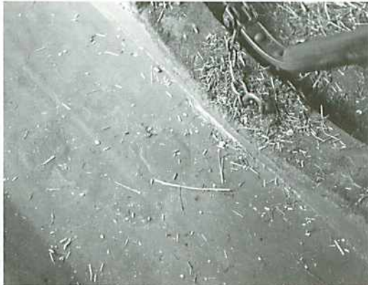
(いつでも新鮮な飼料) 食べ残しが腐敗しないように飼槽の補修
