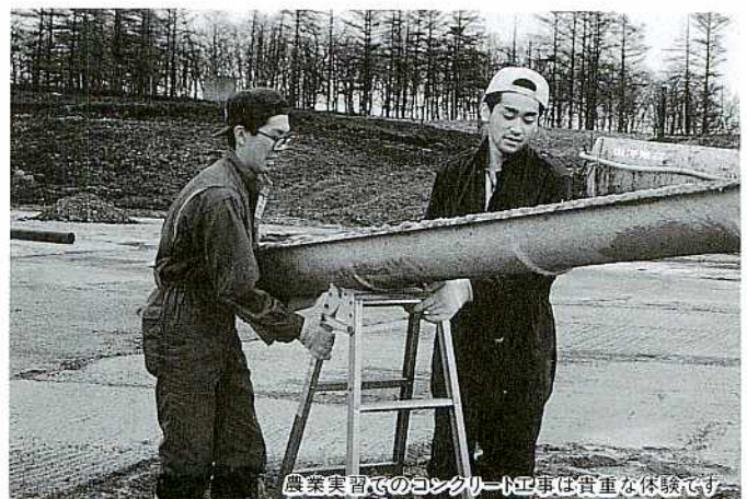
農業実習でのコンクリート仕事は貴重な体験です。
