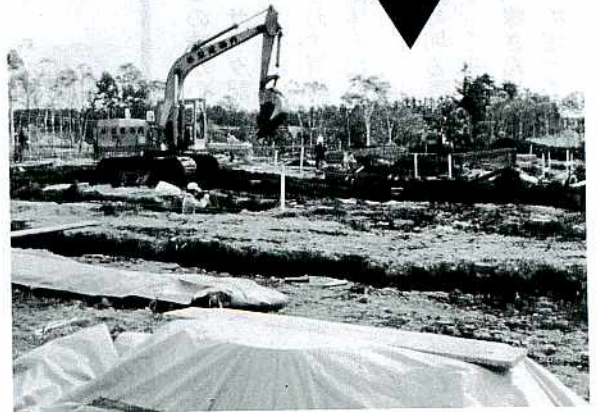
着々と進む工事
