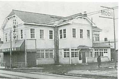
解体直前の事務所
