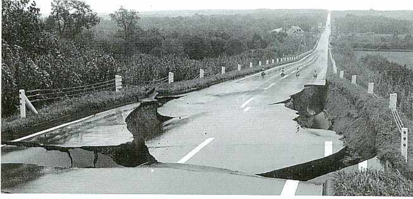
道路が地割れ、地盤沈下で通行止め
