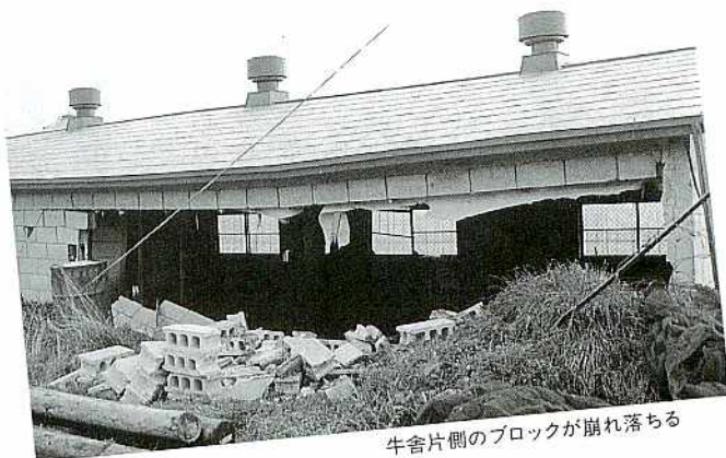
牛舎1階部がつぶれ屋根だけが残る
