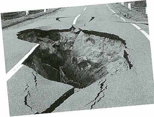
道路が地割れ、地盤沈下で通行止め
