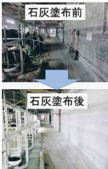
写真3 石灰乳塗布前後の変化
