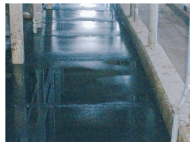
図4 通路用マットの施工例
