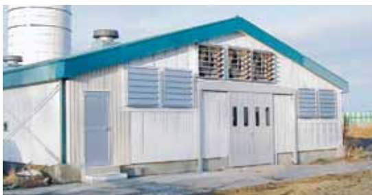
写真1 トンネル換気による暑熱対策
